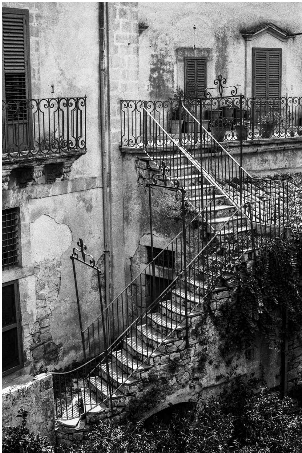
Balconata, ringhiere, scale, giardino privato – Modica
