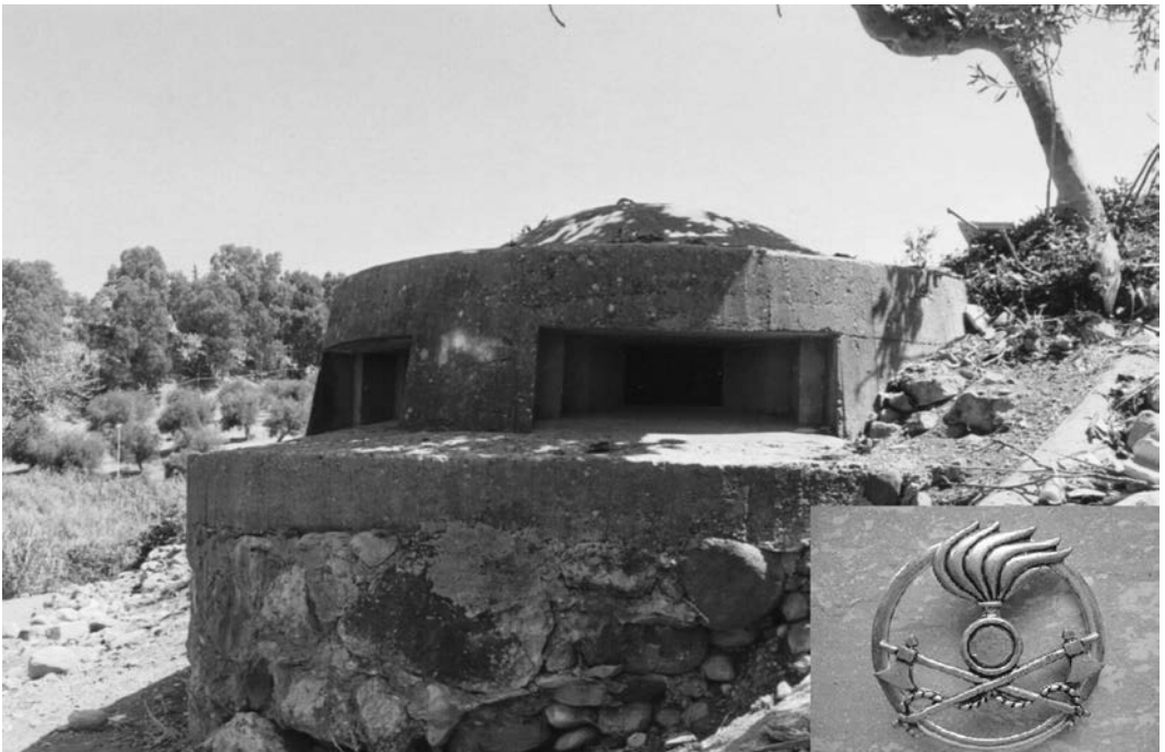
Bunker di contrada Marche, Termini Imerese
