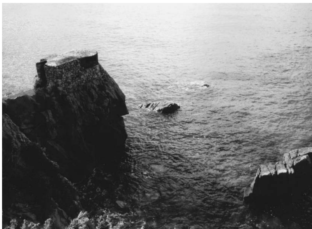
Il Bunker nei pressi della Stazione Ferroviaria di Castelbuono (PA).
