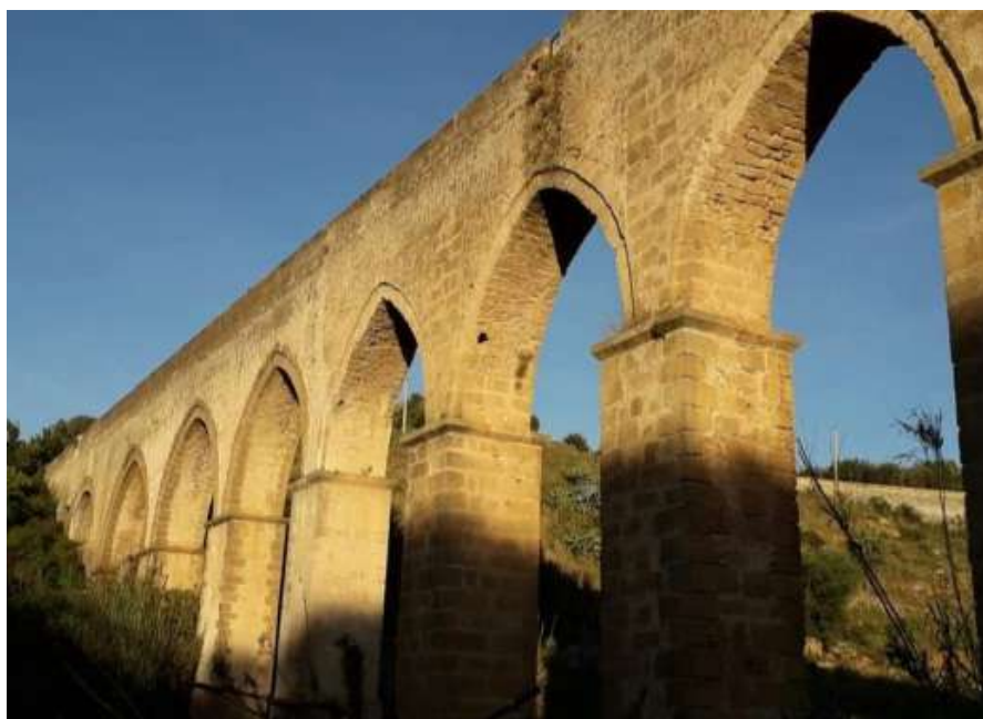
Il ponte acquedotto di Ficarazzi sul fiume Eleuterio
